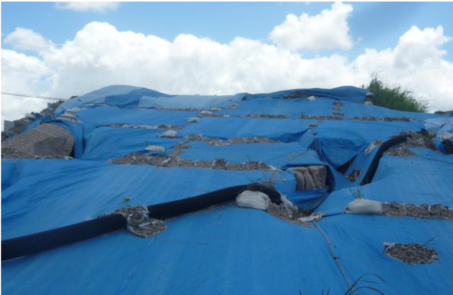
暫定盛土の保護 流出防止
