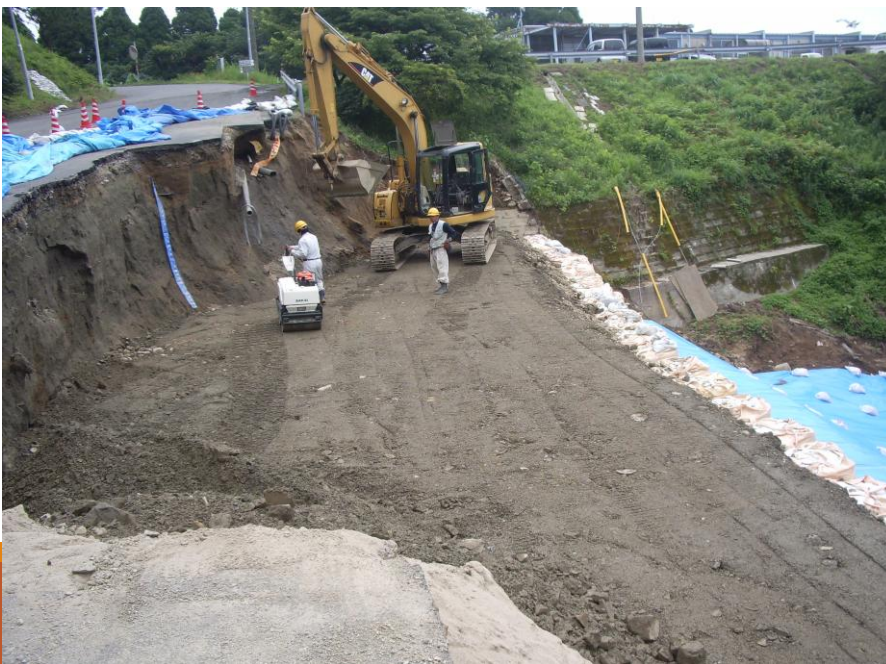
法面や道路の 災害復旧 埋め戻し
